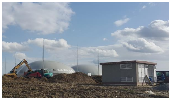
Slika 5.: Trafostanica uz bioplinsko postrojenje u Gregurovcu
