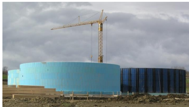
Slika 9.: BPE Orehovec u izgradnji
