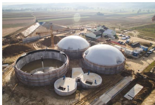
Slika 7.: Izgradnja bioplinare Izvor: Energija bioplin d.o.o., 2016.g
