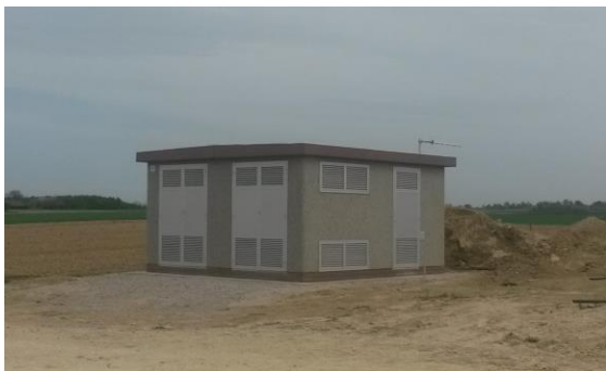
Slika 4.: Trafostanica u Gregurovcu
